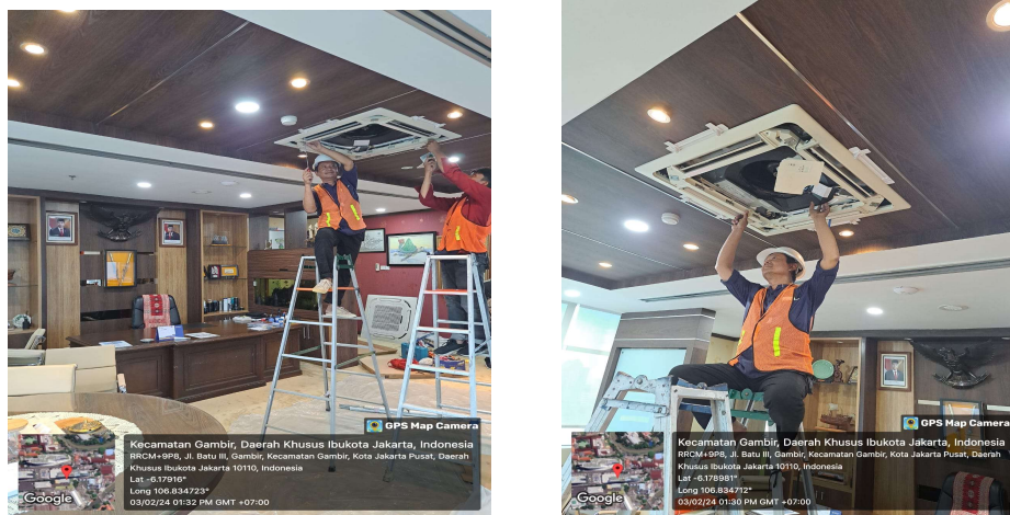
Gambar 28 Pengadaan dan instalasi sarana internal berupa AC Cassete
