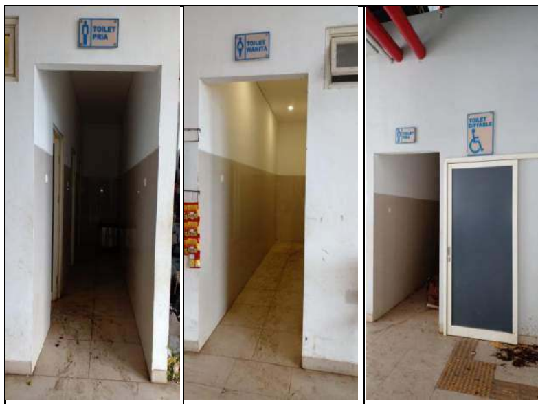
Foto toilet di Pasar Renteng, terdiri dari : toilet pria, toilet wanita dan toilet difabel. Toilet terdapat di setiap los pedagang
