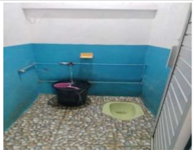
Foto kondisi toilet di Pasar Gerung
