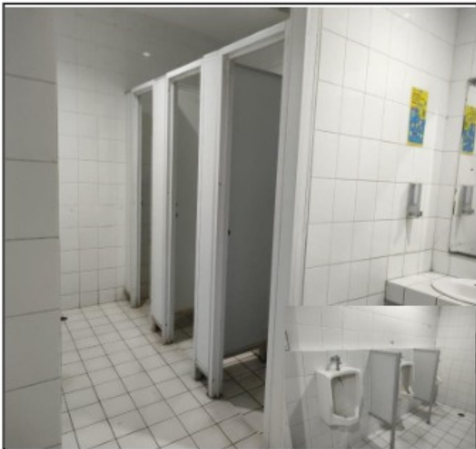
Foto kondisi toilet di Hypermart
