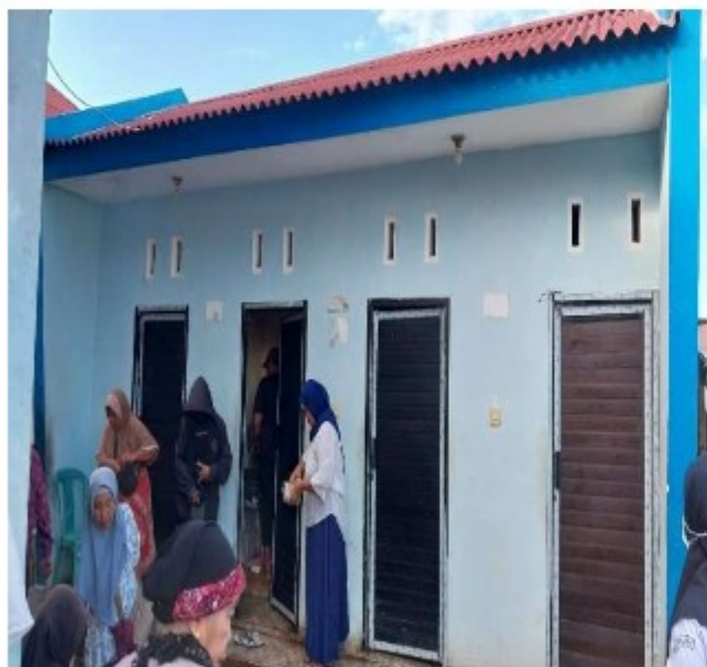
Foto kondisi toilet di TPI Tanjung Luar, terdapat toilet dalam kondisi bersih dan terawat
