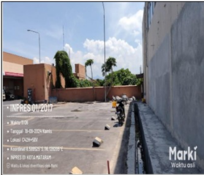
Foto saluran limbah berada diluar bangunan
