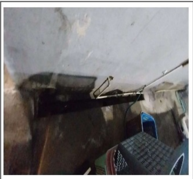
Foto saluran pembuangan di penampungan Lobster Estate
