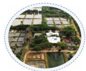
Instalasi Tambak Silvofishery
