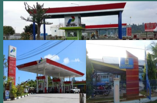
Infrastruktur Energi (Depo Pertamina & PLN)
