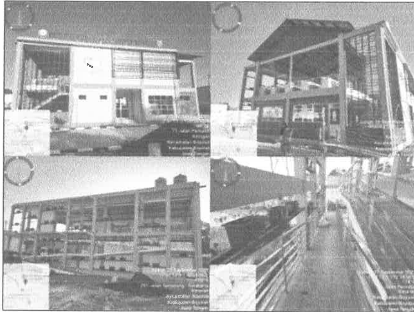
Gambar 16 Progres Pembangunan PIB Boyolali
